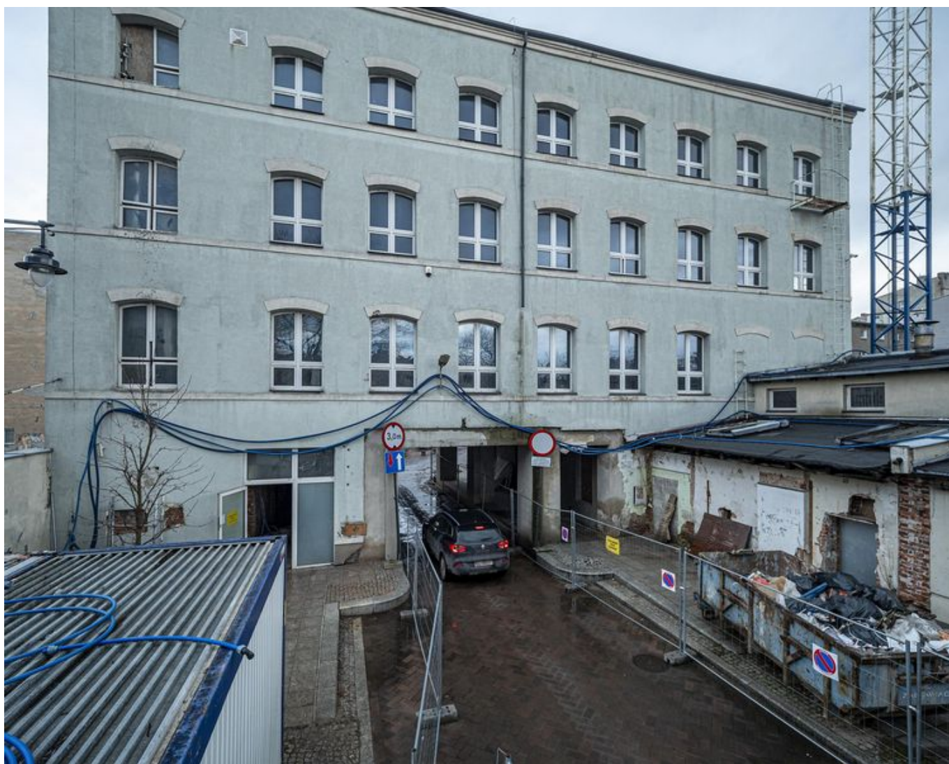
Fabryka przy ul. Tuwima 10 zyska nowe życie , fot. Stefan Brajter / UMŁ
